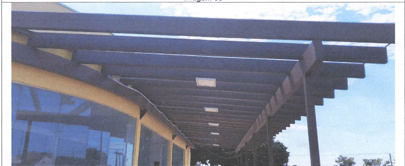
Cobertura área externa
