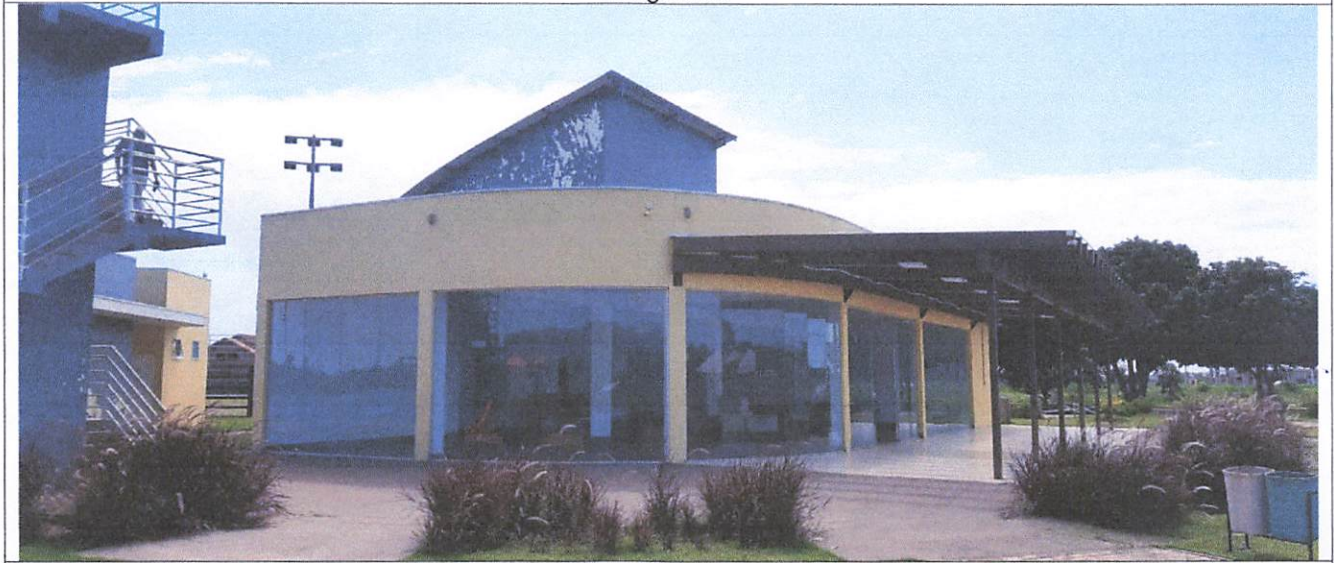
Fachada lateral (oeste)
